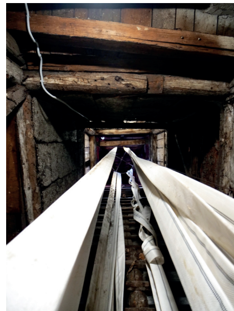
Vo veži Požiarnej zbrojnice sa nachádza historická, no stále využívaná sušiareň požiarnych hadíc .
