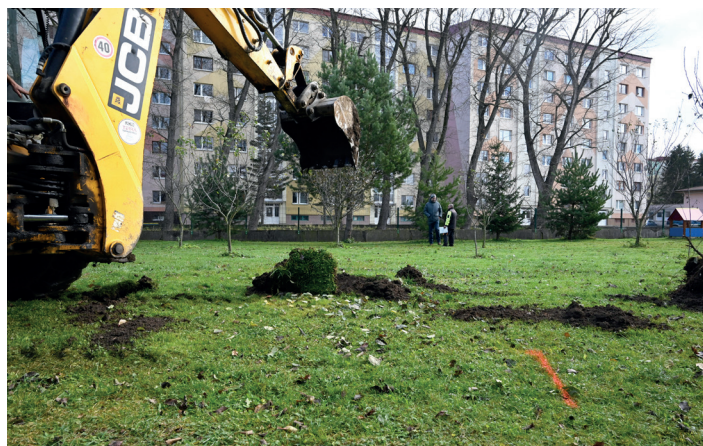
Príprava infraštruktúry vedúcej k zelenej stene v areáli ZŠ s MŠ Nižná brána, snímka zo zrealizovaných prvkov Vodozádržných opatrení I.
