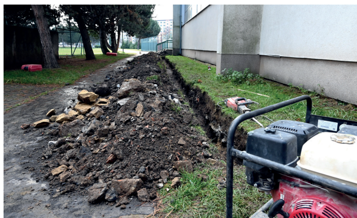
Príprava jám na osádzanie potrubia ústiaceho do retenčnej nádrže. Potrubie zachytáva vodu z odkvapov strechy školy, snímka zo zrealizovaných prvkov Vodozádržných opatrení I.
