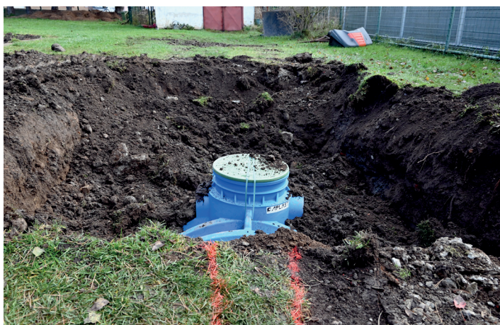
Zakopávanie retenčnej nádrže v areáli ZŠ s MŠ Nižná brána, snímka zo zrealizovaných prvkov Vodozádržných opatrení I.
