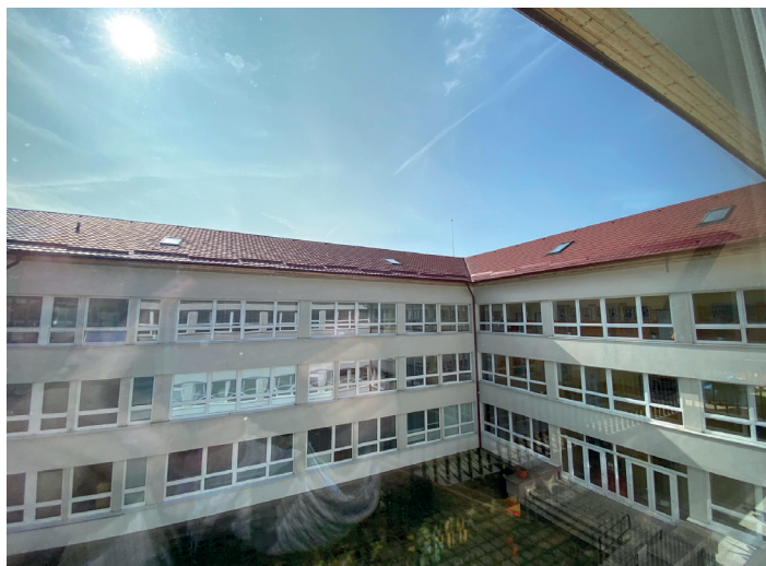
Átrium Spojenej školy Dr. Daniela Fischera počas slnečného dňa. Na strechy tejto školy pôjde panelov viac.
