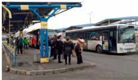
Zastarané nástupištie rozozraté hrdzou výrazne znižujú komfort a úroveň cestovania.
