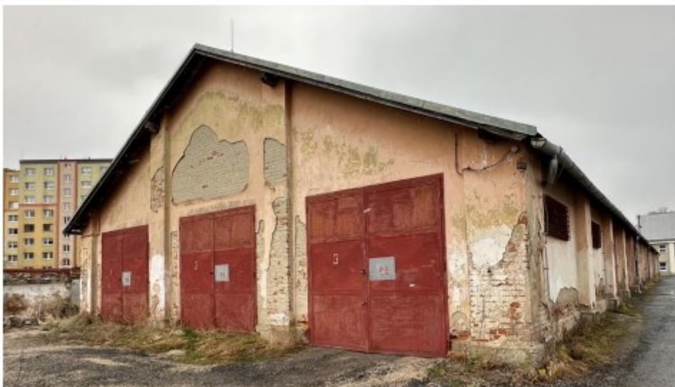
Obrázok 6 – Pohľad severnú a východnú stenu objektu
