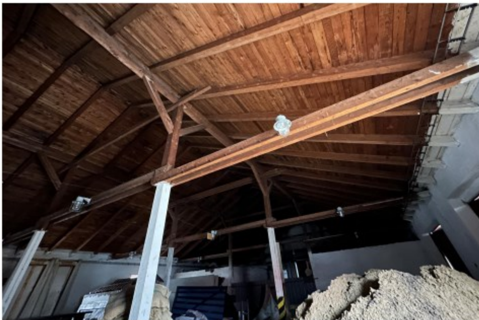
Obrázok 8 – Pohľad na interier objektu
