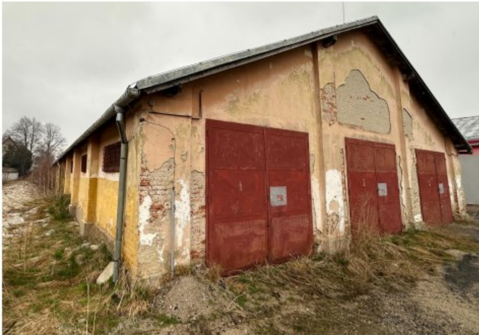
Obrázok 7 - Pohľad južnú a východnú stenu objektu
